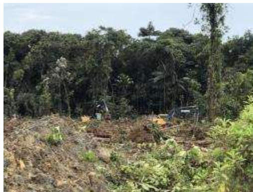
Fotografía 11. Proceso de remoción cobertura vegetal con maquinaria – retroexcavadora
